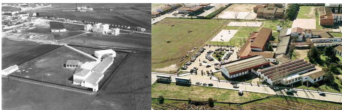
Fig. 19. El edificio en 1967 y en 2001.
