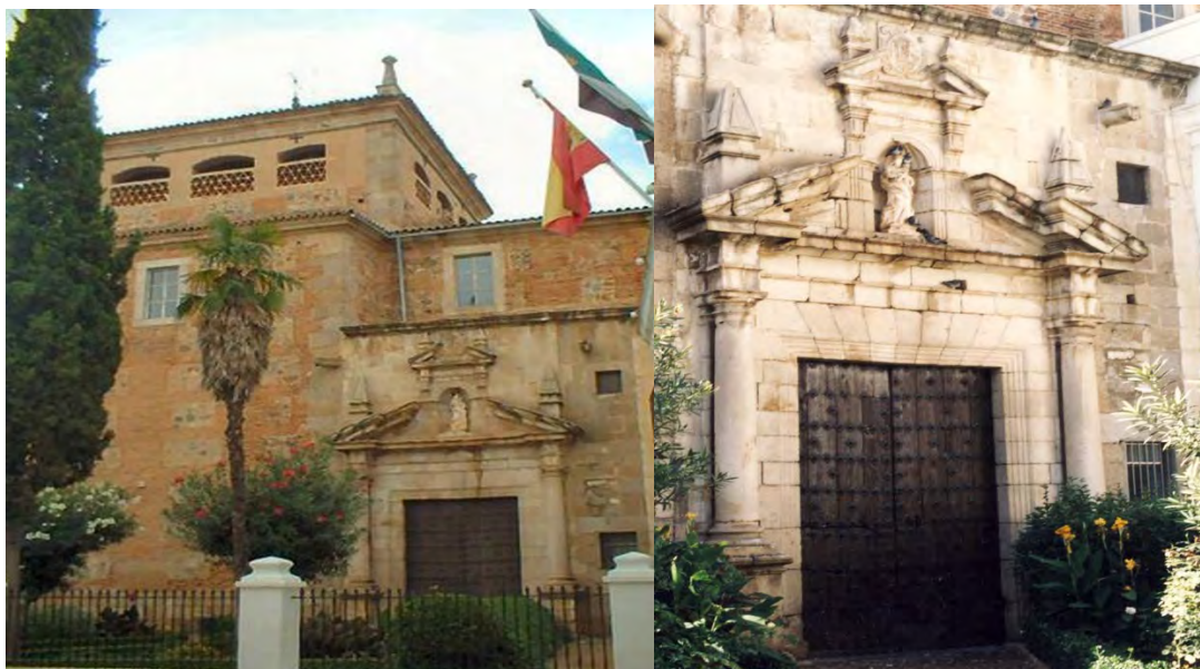
Exterior de la iglesia de Santa Clara
